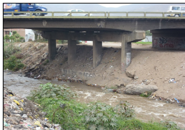
Fig. N°7: Se pueden observar los pilares que no han sido afectados por la dinámica fluvial del río.
