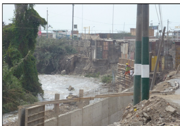
Fig. N°5: Viviendas de madera y concreto asentadas al borde del río. Posible socavación a largo plazo.
