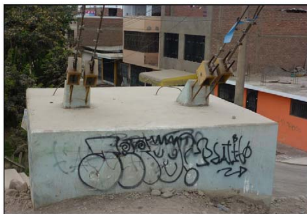
Fig. N°5: Cabezal de anclaje del puente.
