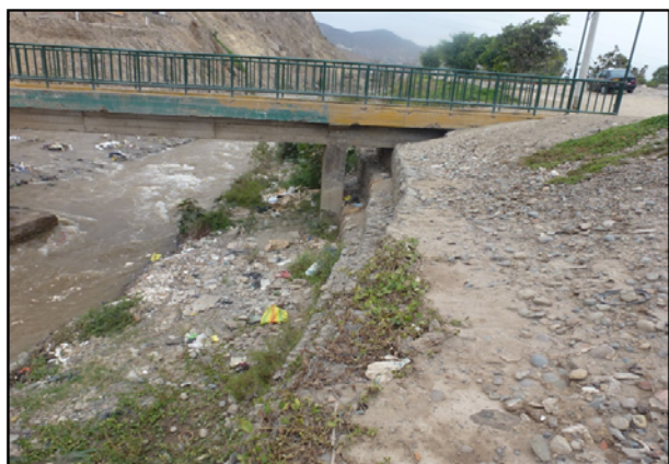
Fig. N°4: Apoyo en la margen izquierda del puente. Protección con gaviones.
