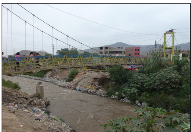
Fig. N°6: Vista del puente actual y pilar de concreto de puente antiguo.
