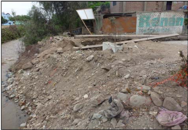
Fig. N°4: Estribo derecho del puente en proceso de construcción.
