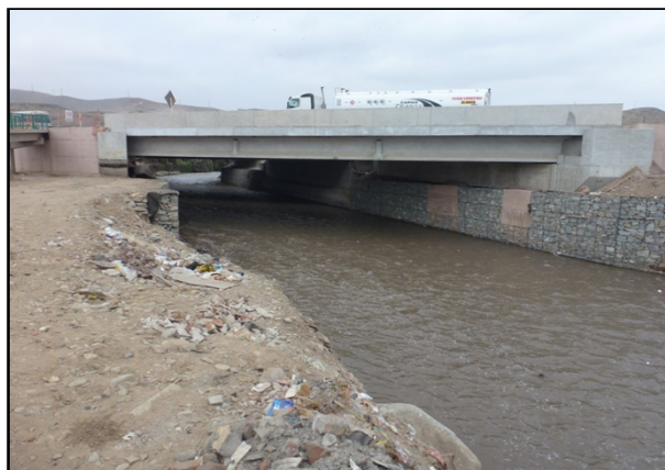
Fig. N°2: Puente Gambeta recientemente contruido y con protección ribereña de gaviones.
