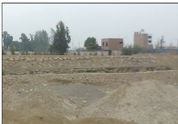
Fig. N°4: Enrocado de protección por la margen derecha del río (h=3m).
