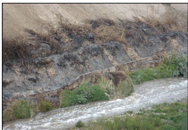
Fig. N°4: Quema de vegetación y muro volcado en el pie del talud de la margen derecha.
